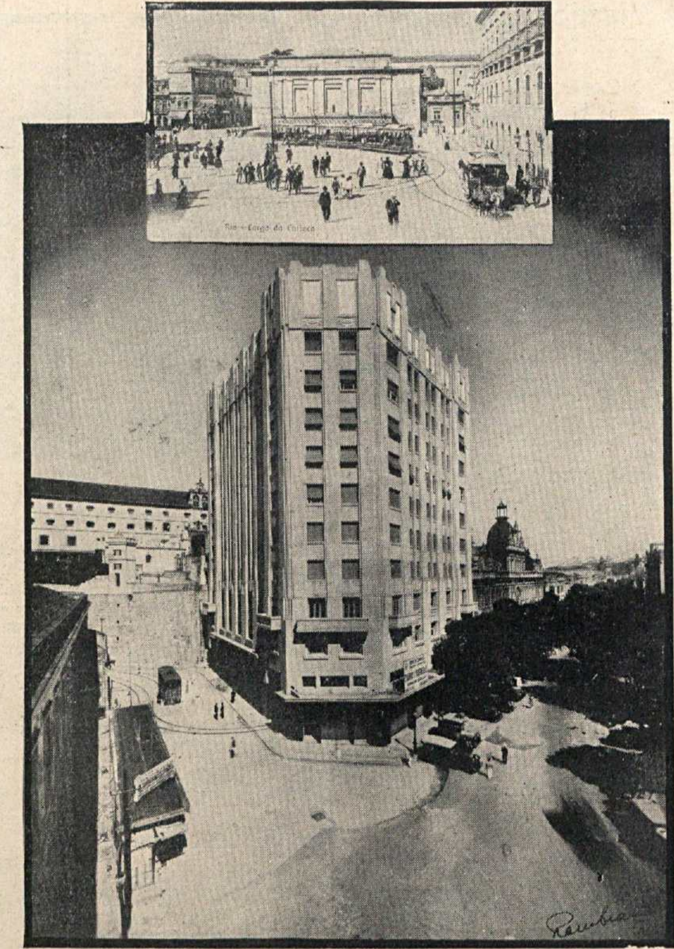
O edificio onde está localizada a Galeria Carioca e ao fundo o Convento de Santo Antonio. A pequena gravura ao alto, mostra um aspecto do Largo da Carioca em 1909, quando era ponto de partida dos bondes da Cia. Jardim Botânico. Ao canto, havia a escada de acesso á estação dos bondes de Santa Thereza.
