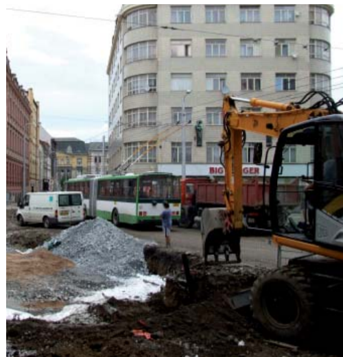
Ještě v červenci 2008 vypadal prostor u Mrakodrapu bezútešně, o 5 měsíců později tu obnoví plný provoz všechny linky. I po dobu této náročné stavby zůstal zachován provoz trolejbusů mezi Muzeem a Zimním stadionem. Foto Jiří Kohout
