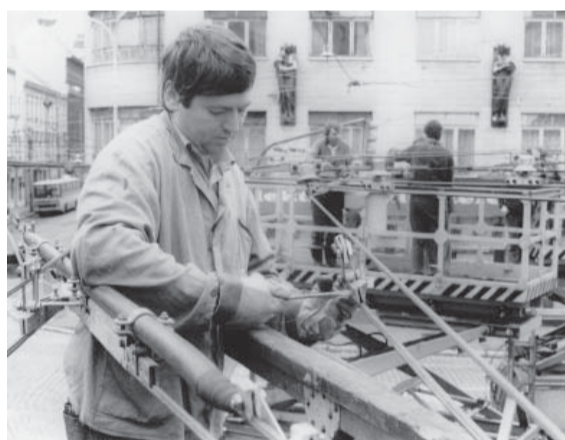
Josef Vracovský se v 80. letech osobně podílel na rekonstrukci trolejového vedení křižovatky Mrakodrap. Foto archiv J. Vracovský
