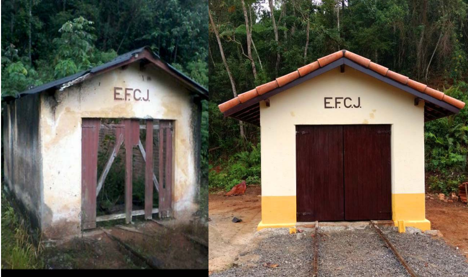
Casa de trole antes e depois da reforma feita recentemente
