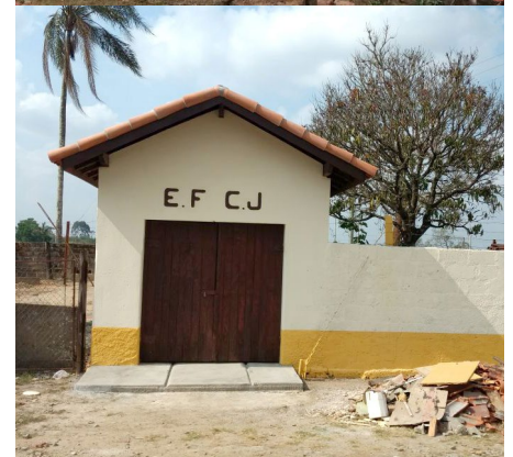
Casa de ferramentas de São Judas antes e depois da reforma
