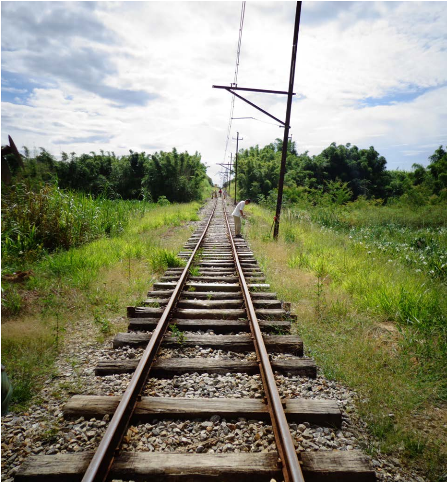
Funcionários cadastram dormentes no km 12 da ferrovia
