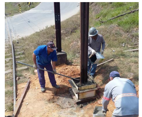
Equipe do setor de rede aérea durante troca de poste
