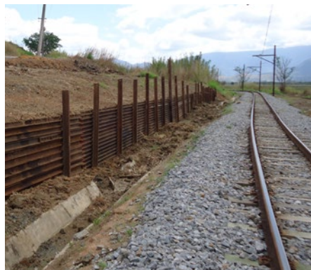
Trabalho protege a via permanente de erosão
