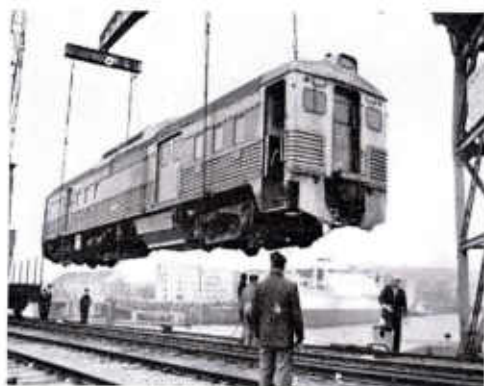
Der amerikanische Schienenprüfwagen wird im Hamburger Hafen auf ein DB-Gleis abgesetzt.
