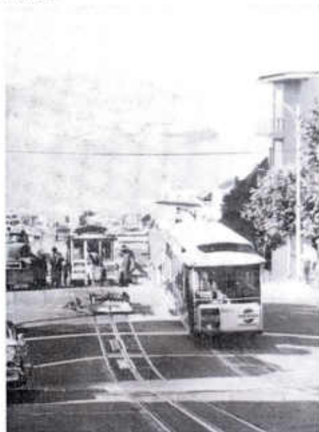
Tagelang stand die Kabelbahn von San Francisco still, das abgerissene Drehgestell des Wagens 517 stand auf der belebten Strassenkreuzung, auch der talwärts fahrende Wagen 503 blockierte den Querverkehr auf der Hyde Street.
