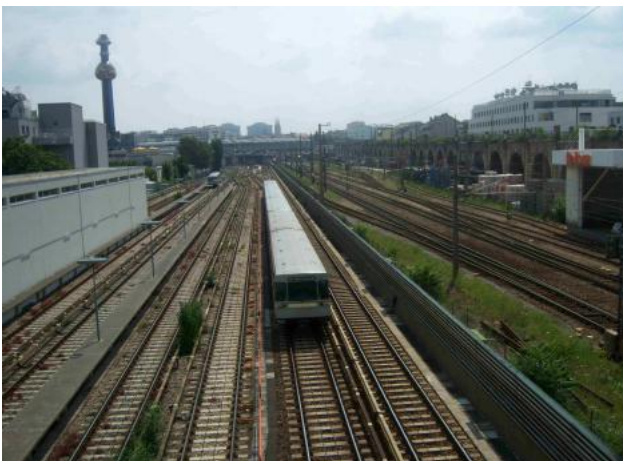
Blick auf den U-Bahn Betriebsbahnhof Wasserleitungswiese
