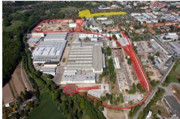
Produktionshallen und Gleisanlagen in Bautzen
